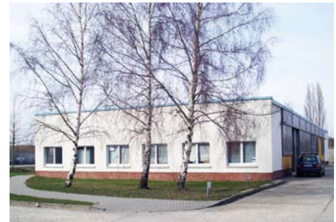
Das Berufsbildungszentrum-Bau Wernigerode befindet sich seit 1. September 2009 in unmittelbarer Nähe der Berufsbildenden Schulen im Gießbergweg.
