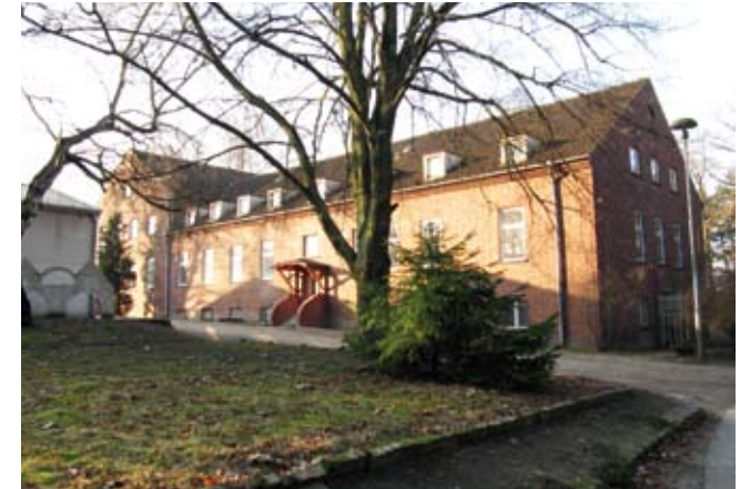
Das Berufsbildungszentrum-Bau Salzwedel befindet sich in unmittelbarer Nähe zur B 190 und B 71 in der Siedlung des Friedens.
