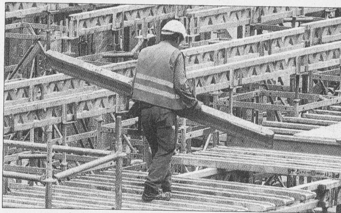
Ein Bauarbeiter auf einer Baustelle. Die Bauwirtschaft in Sachsen-Anhalt fordert einen „klaren Kurs in der Baupolitik“. Foto: dpa
