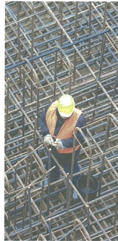
Bauarbeiter errichten ein Stahlgeflecht.
