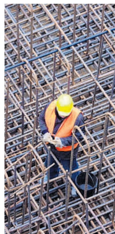
Bauarbeiter errichten ein Stahlgerüst. FOTO: DPA
